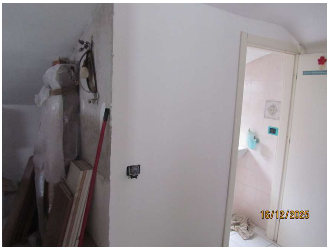
FOTO N. 23 – TRAMEZZATURA DEL BAGNO
