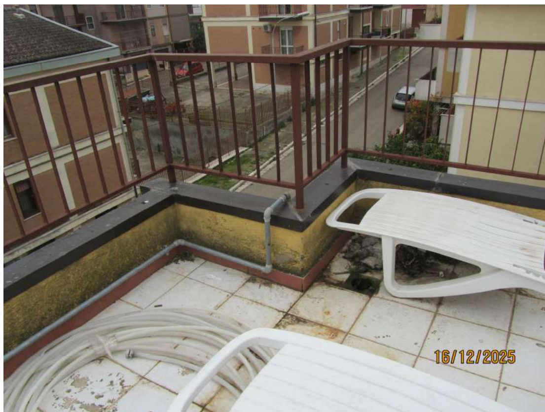
FOTO N. 28 – SCORCIO DEL TERRAZZO CON AFFACCIO SU VIA MONTEGRAPPA
