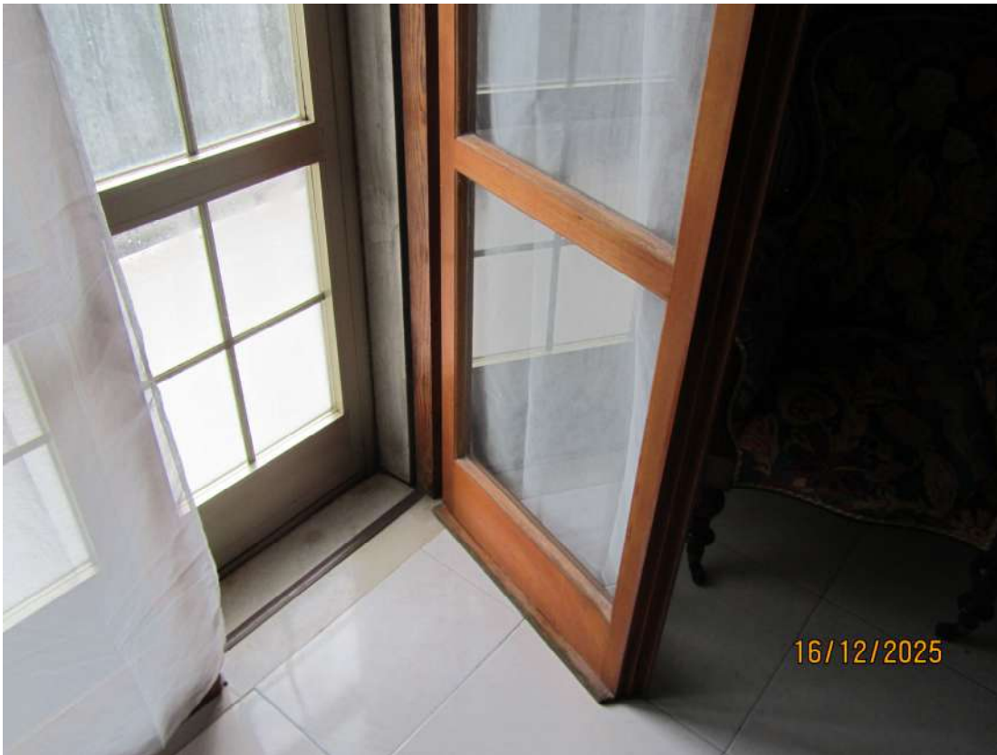
FOTO N. 19 – PARTICOLARE INFISSI ESTERNI
