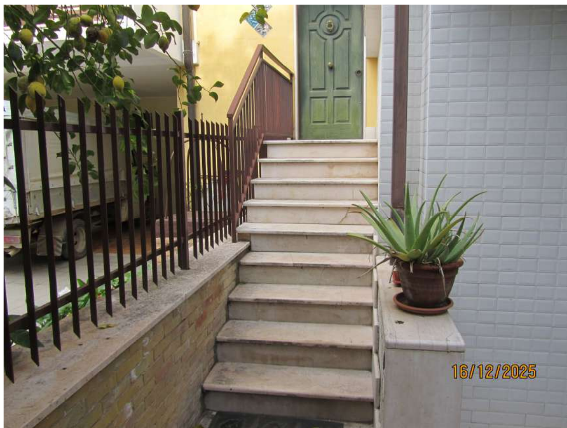
FOTO N. 4 – VISTA PORTA D'INGRESSO ABITAZIONE
