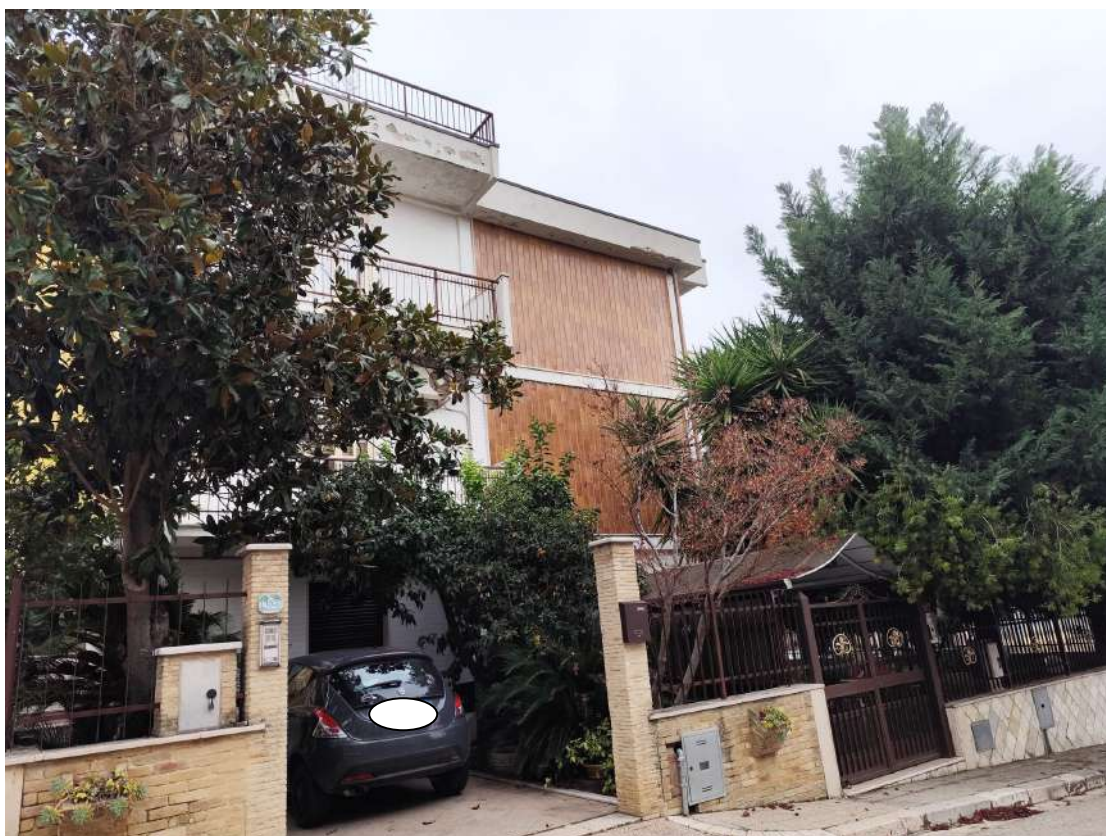
FOTO 1 – INGRESSO ESTERNO SU VIA MONTEGRAPPA
