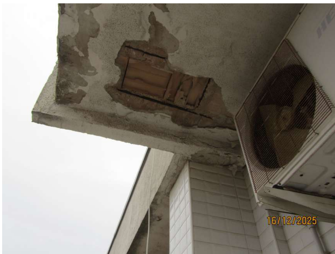
FOTO N. 16 – PARTICOLARE SOTTOCIELO BALCONE – STATO MANUTENZIONE
