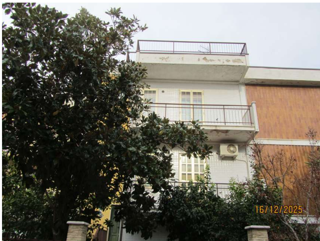
FOTO N. 3 – PROSPETTO SU VIA MONTEGRAPPA
