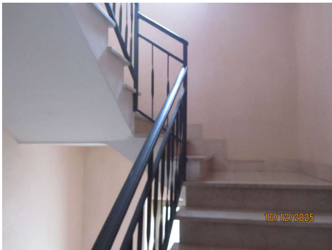
FOTO N. 5 – VISTA INTERNA SCALA
